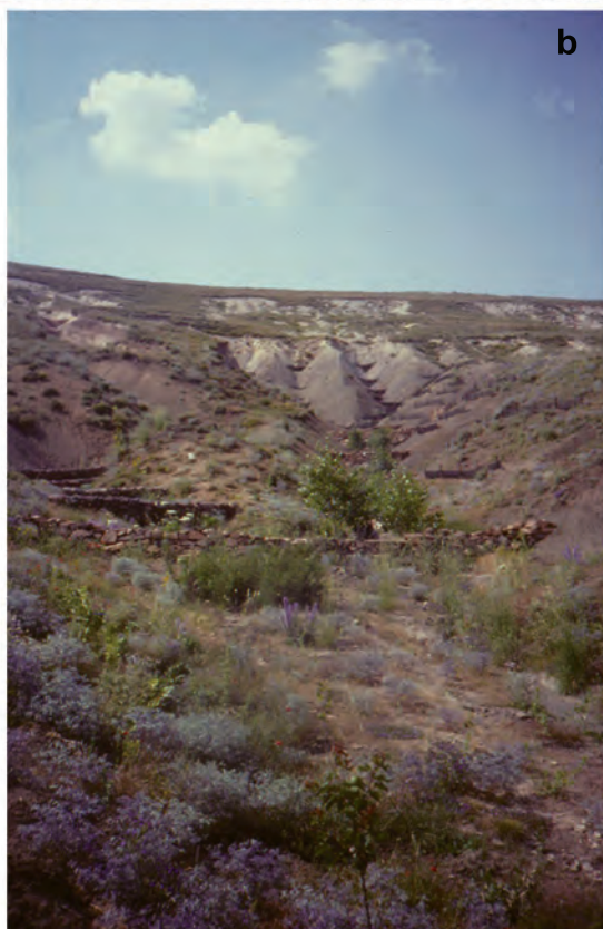
a : vingt ans après l'aménagement physique (seuils divers) et biologique (plantations de diverses espèces d'herbes et d'arbres), la ravine reverdie a résisté aux dégradations durant la guerre.
