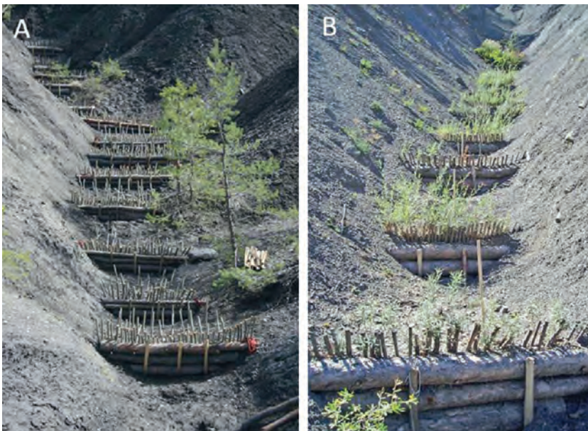
a : ouvrages d'ingénierie écologique au moment de leur installation, b : après une saison de végétation.
